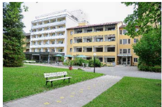
Vor Beginn der jetzigen Baumaßnahmen ...
